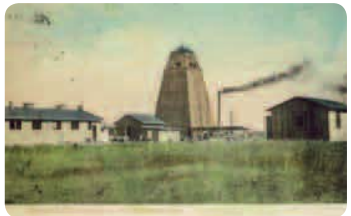
Puits de mine en cours de fonçage – 1912
