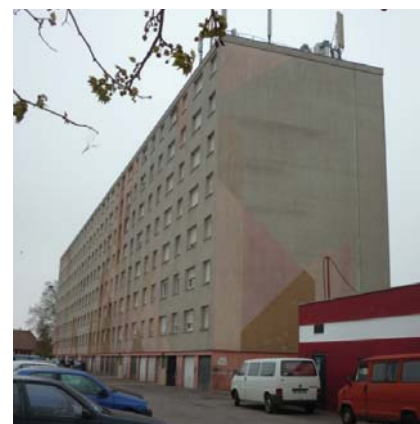
Immeuble du Rossberg, prochainement démolie
